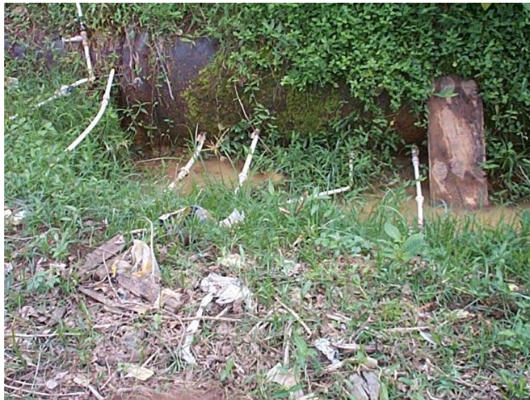
FLAGRANTE DE LIGAÇÕES CLANDESTINAS EM ADUTORA
